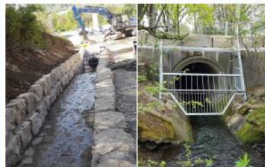
Einlaufbauwerke mit optimiertem Rechen
