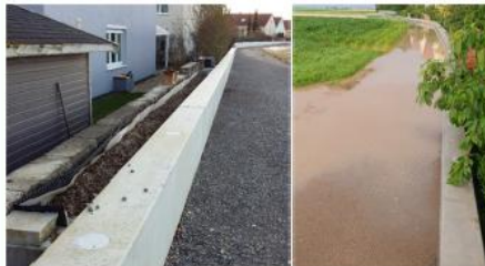
Mauer mit Rückhalt
