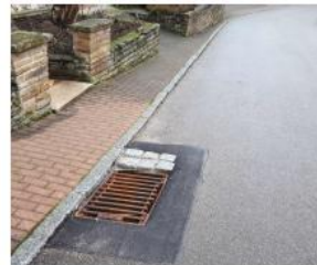
Bergeinlauf (mit Optimierung)
