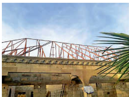
Derzeitiger Stand Gebäudeerweiterung mit Dachkonstruktion
