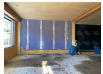
Die Holzdecke in der künftigen Mensa ist schon fertig
