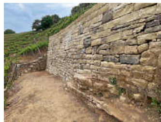
50 Quadratmeter Fläche misst die sanierte Trockenmauer
