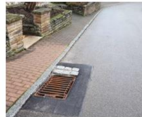
Bergeinlauf (mit Optimierung)
