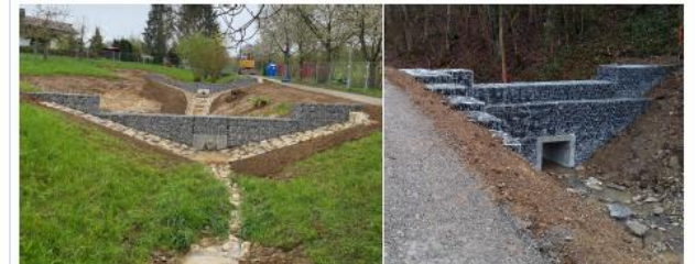
Geröllfang mit Retentionswirkung
