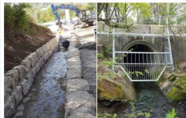
Einlaufbauwerke mit optimiertem Rechen
