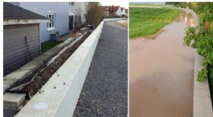
Mauer mit Rückhalt
