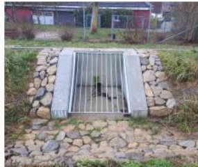
Verwallung und Einlaufbauwerk
